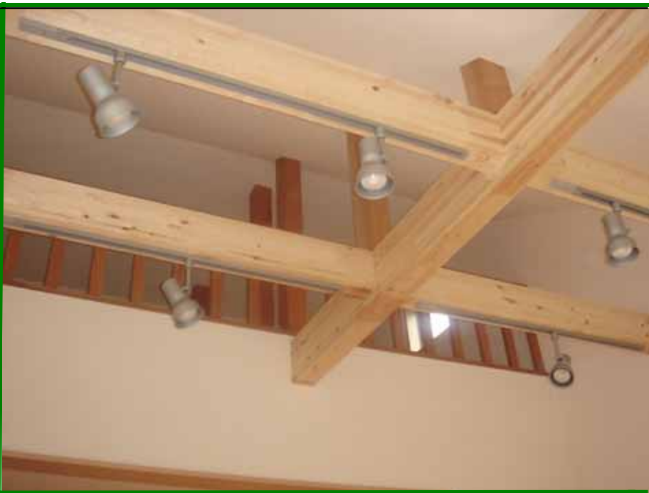
Y様邸新築工事施工
